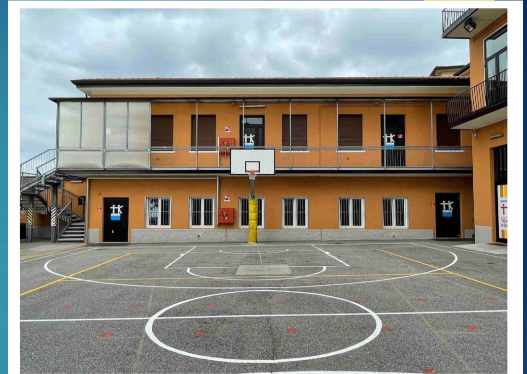
Risanamento e tinteggiatura facciata mensa e ballatoio (inclusa sostituzione inferriate)
