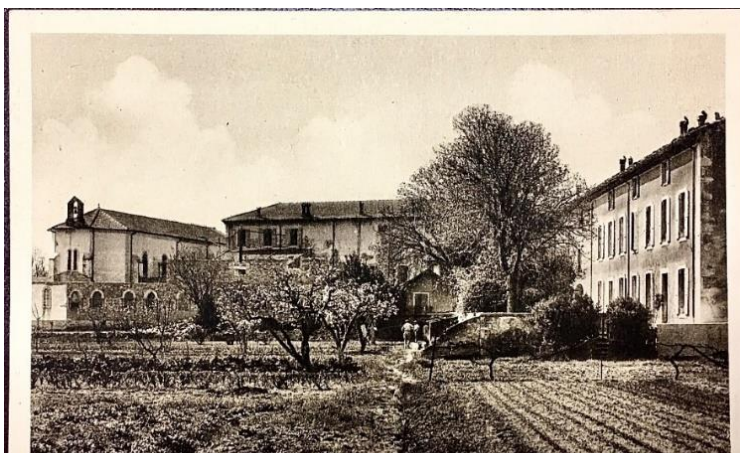
Cappella provvisoria e terreno per la costruzione della nuova chiesa
